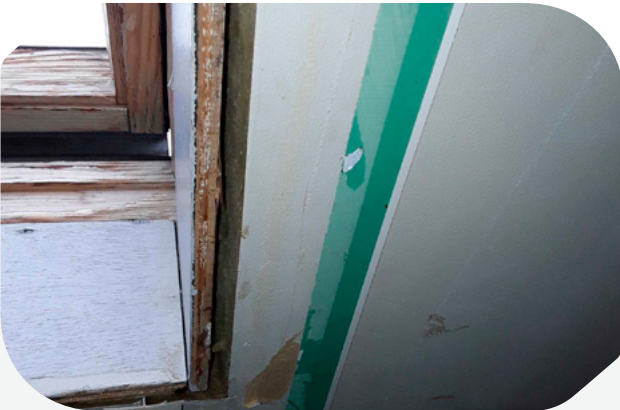
Dakraam betimmering herstellen
