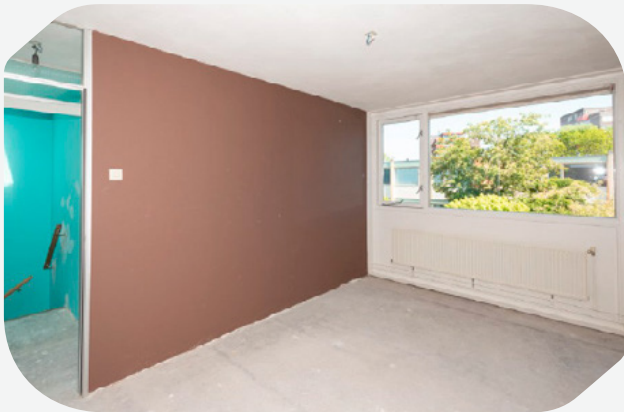
De wand moet na 2x schilderen een dekkend zijn
