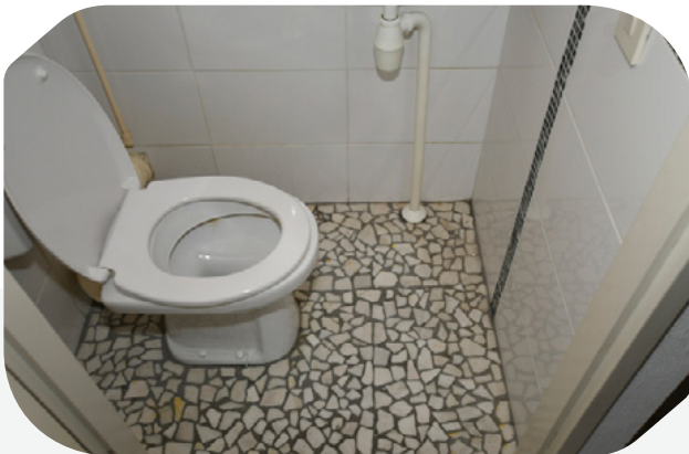
Tegelwerk niet standaard
