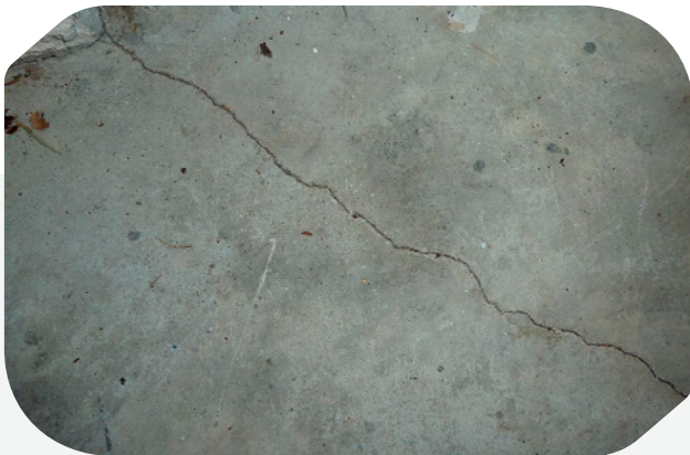
Krimpscheurtjes in vloer (<3 mm)
