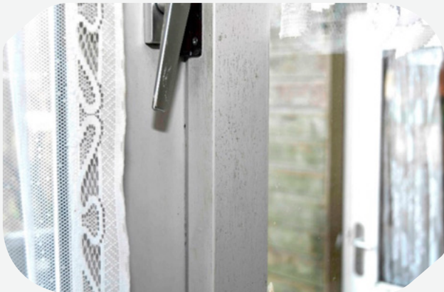
Geground kozijn, schilderwerk voor de bewoner
