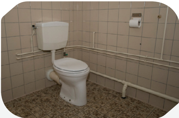
Toilet in goede staat
