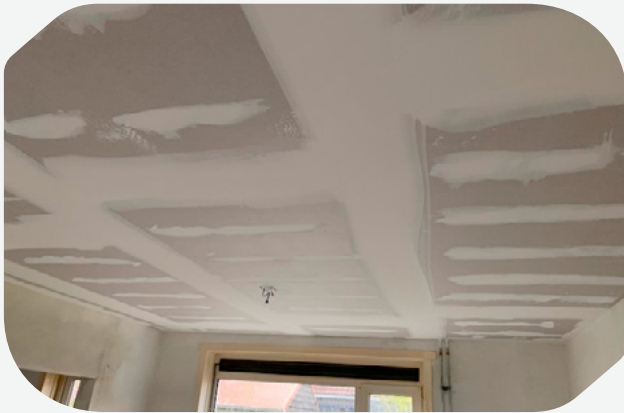
Nieuwe gipsplaten zijn dichtgesmeerd en schilderklaar
